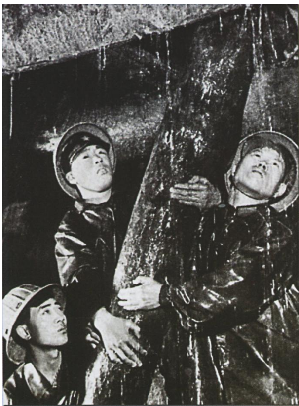
▲进行支撑作业
