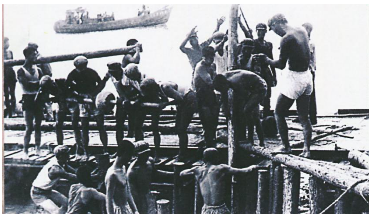
▲在辽阳太子河决口处打桩筑堤
