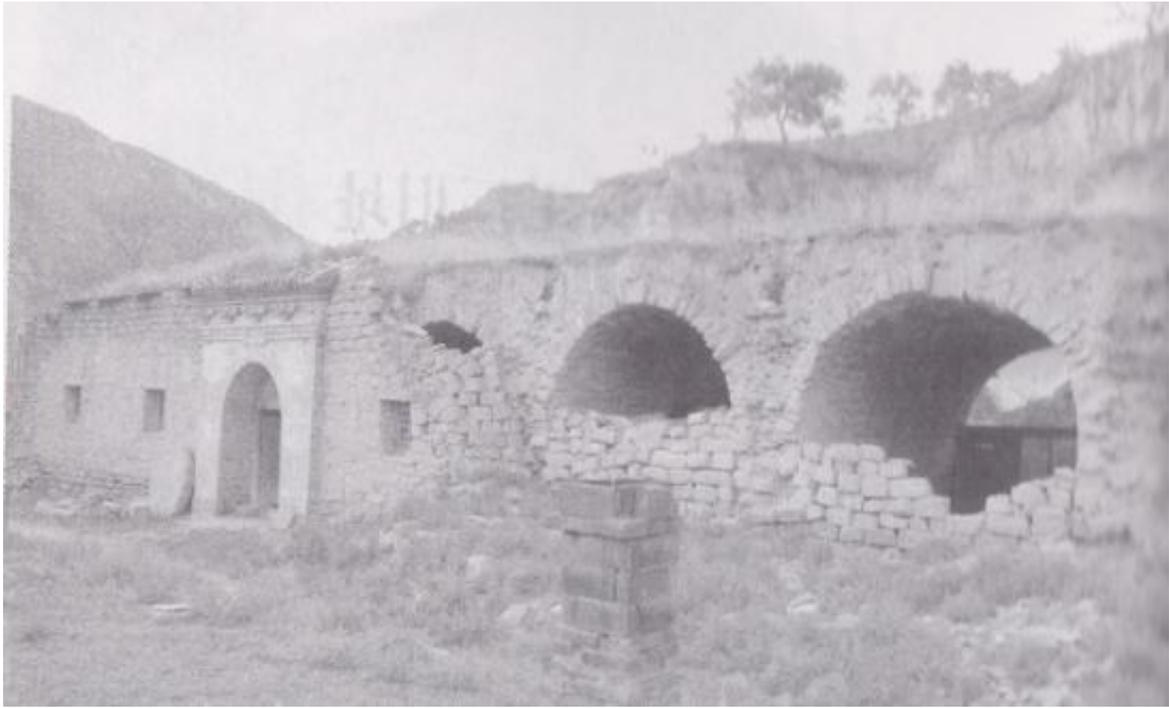
院布局，院内有南北相向 2 排旧石窑，每排窑洞各 6 孔。窑洞均进深 8 米，宽 3.2 米，高 4 米。院子南北宽 22 米，东西长 36 米，整个院落占地面积 420 平方米。
